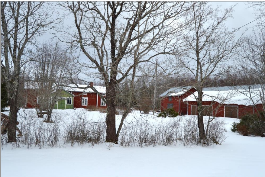
Bild 32. Den gamla huvudbyggnaden och gårdsmiljön på Lintula på vägens östra sidan har anvisats med skyddsbezeichnung i strandgeneralplanen.
