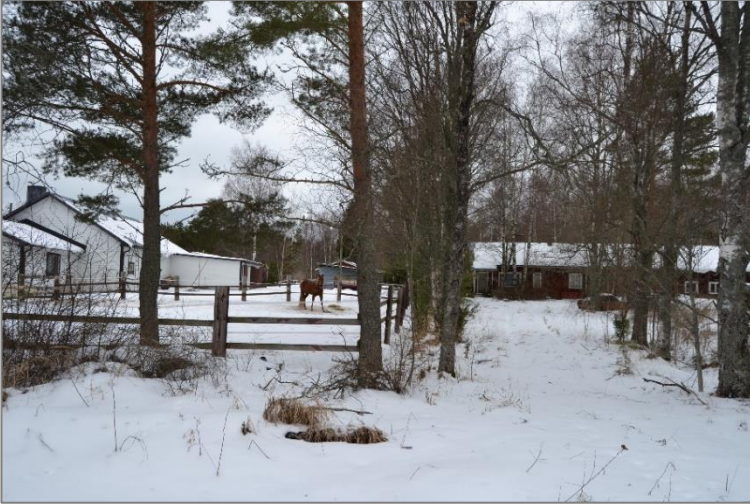
Bild 17. Närpesvägen 144 (objekt 6) byggdes mellan 1957 och 1971. Bostadshuset har byggts ut åtminstone i mitten av 1990-talet. Det långsmala uthuset (till höger på bilden) har bevarat sina ursprungliga drag från uppskattningsvis slutet av 1950-talet.
