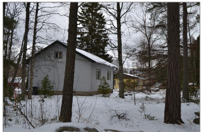
Bild 14. Borgmästarvägen 7 (objekt 4) byggdes mellan 1957 och 1971. Borgmästarvägen 3 (objekt 3) byggdes mellan 1971 och 1986.
