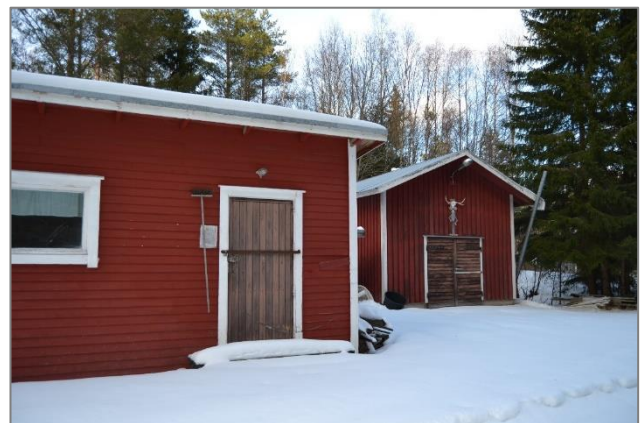
Bild 26. Till vänster kontoret med fasad av lockpanel och till höger förrådet med fasad av stående panel.
