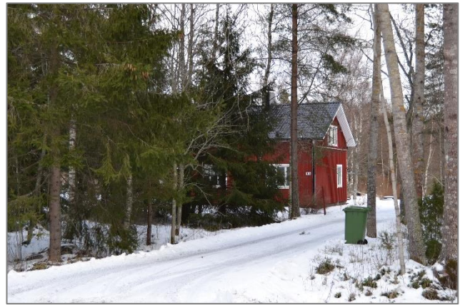
Bild 12. Skrattnäsvägen 45 (objekt 2) hör liksom sin granne till de äldsta husen i området. Bostadshuset i 1½ plan med åstak och fasad i stående brädfodring har bevarat de drag som vittnar om tidpunkten för uppförandet. På den plats där det tidigare fanns ett gammalt uthus byggdes en ny bastu- och ekonomibyggnad i slutet av 1990-talet. (KRIS.)
