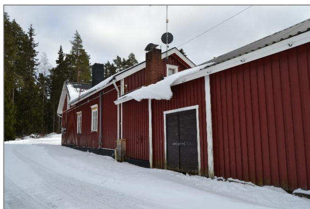
Bild 35. Huvudbyggnadens fasad mot norr. Grunden till den gamla delen (närmast på bilden) har byggts med natursten.
