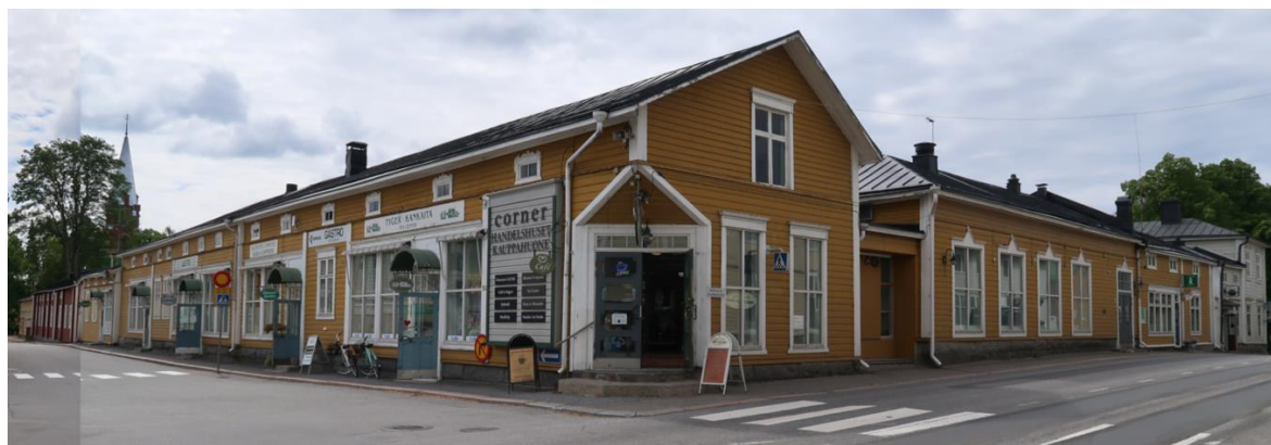
Kuva 10. Ote rakennusinventoinnista, kohde nro 1 – Cornerin kauppahuone.
