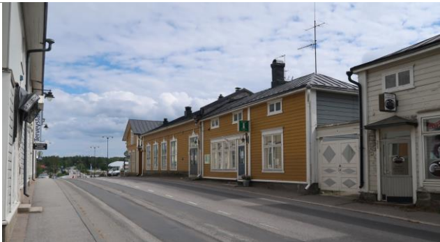
Korttelin 238 Raatihuoneenkadun puoleisia julkisivuja
