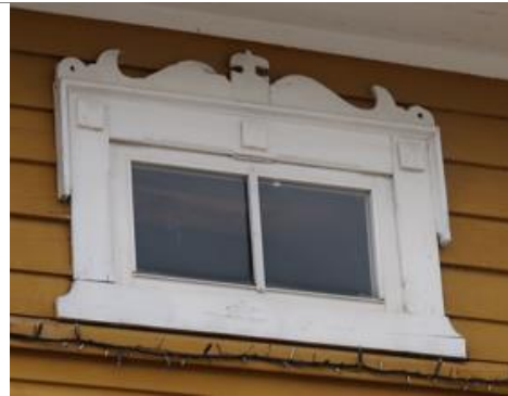
Koristeellinen ullakkoikkunan vuorilaudoitus.
