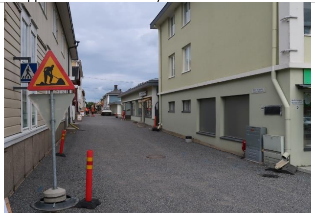
Itäinen Pitkätie Kauppatorilta pohjoiseen
