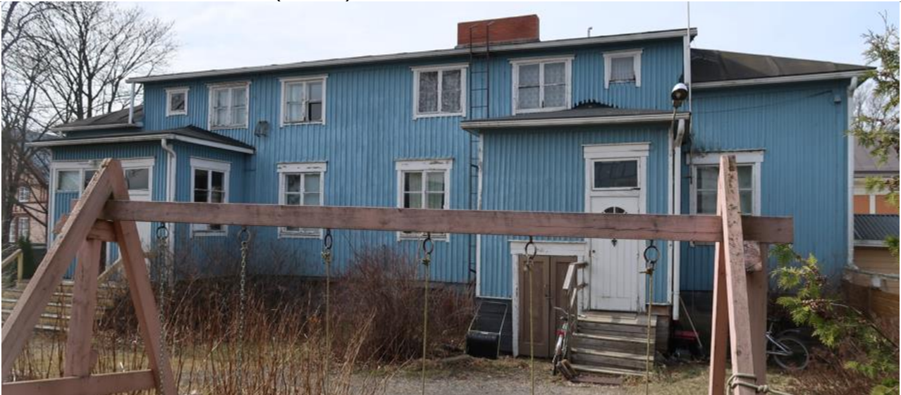
Julkisivu sisäpihalle (itään).
