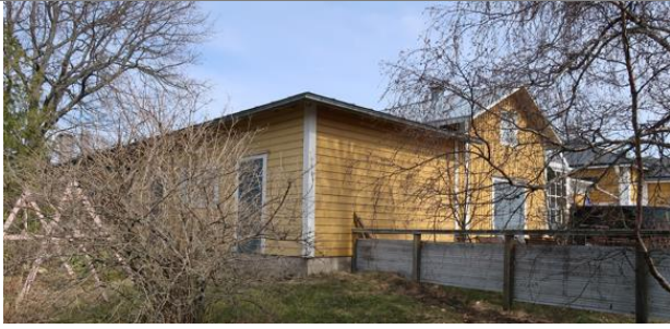
Piharakennus on rakennettu kiinteästi naapurirakennukseen.
