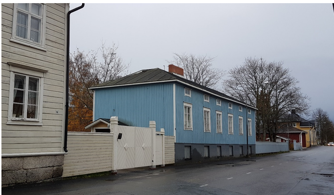
Bild 11. Utdrag ur byggnadsinventeringen, objekt nr 2, Västra Långgatan.
