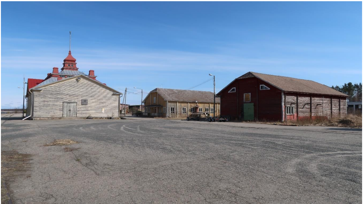
Kuva 8. Paikallisesti merkittävän sataman vanhan rakennuskannan kokonaisuus etelästä pohjoiseen kuvattuna.
