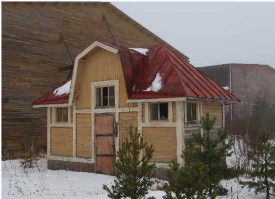
Kuva 21. Sataman vanha käymälärakennus.
