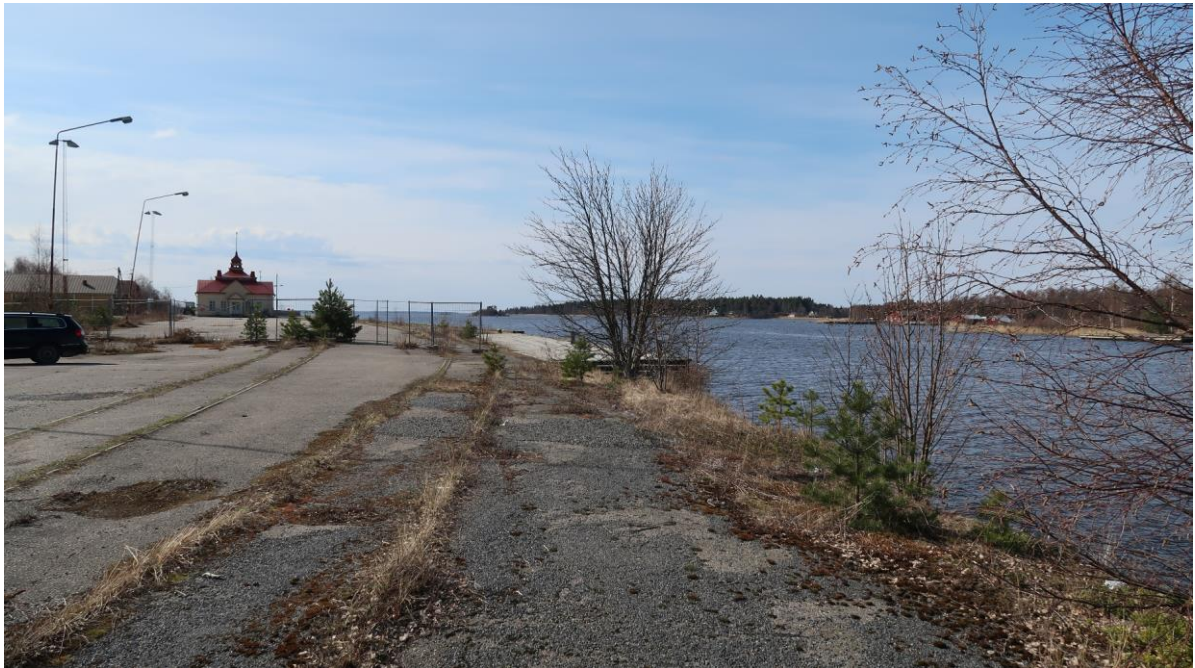
Kuva 5-9. Raiteita satama-alueella kuvattuna.
