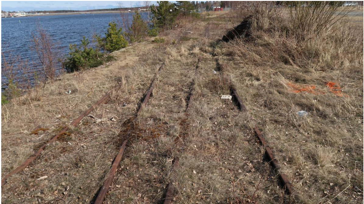
Kuva 5-8. Raiteita satama-alueella kuvattuna.
